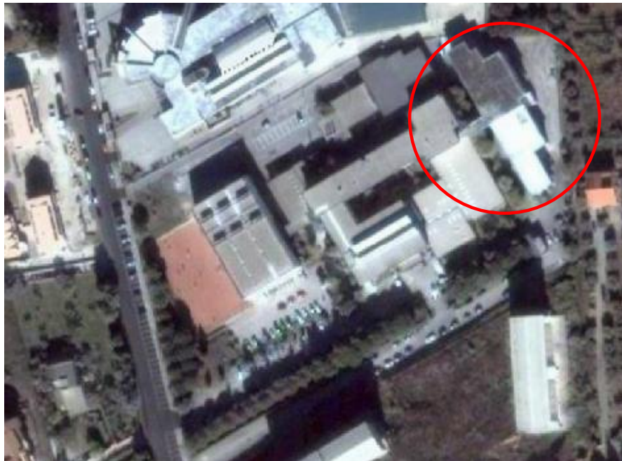
Corpo di fabbrica oggetto dell'intervento
