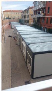
ITIS L. Savoia Chieti Aule prefabbricate – lavori preliminari adeguamento sismico
