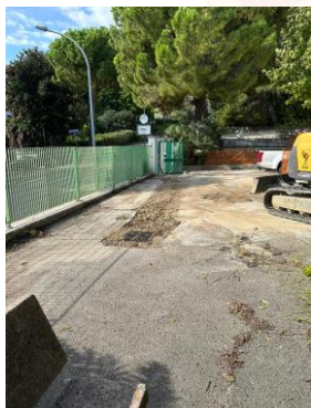
Liceo Scientifico «A. Volta» Francavilla al Mare Sistemazione esterna
