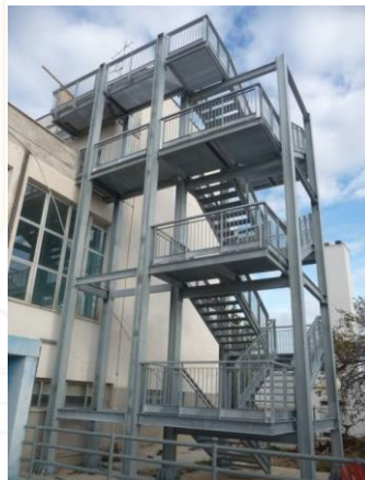
I.I.S. RIDOLFI-ZIMARINO DI SCERNI - ADEGUAMENTO ANTINCENDIO CONVITTO ITA "Ridolfi" - (Fondi PNRR)
