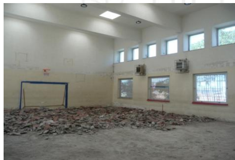
I.I.S. "PALIZZI" DI VASTO - RIFACIMENTO PAVIMENTAZIONE PALESTRA (Fondi PNRR)
