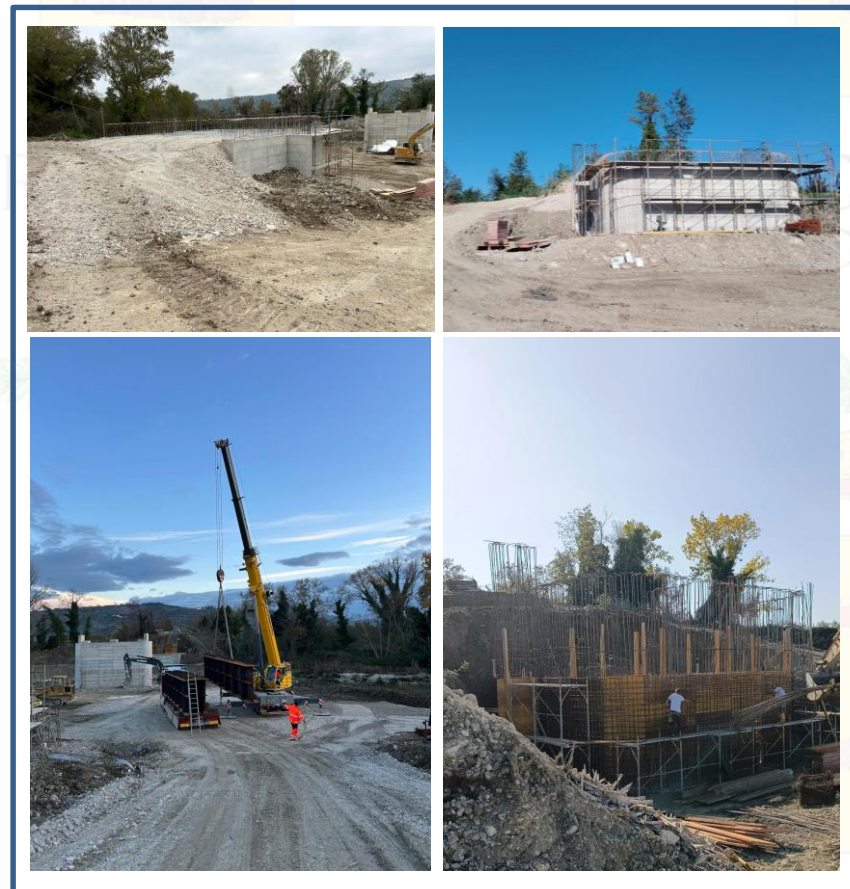
Nuovo ponte Guastacconcia
