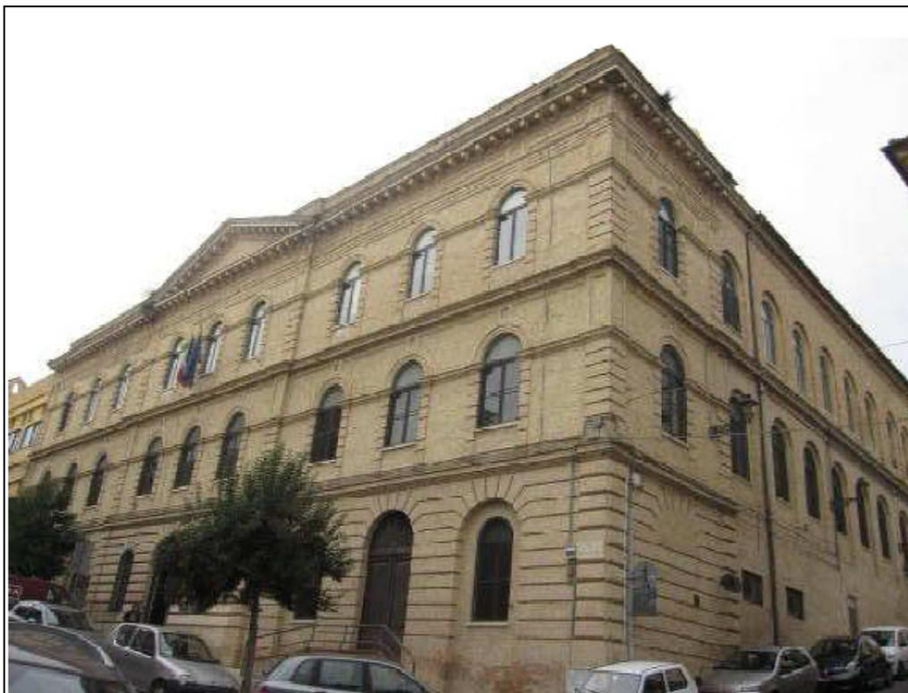
Il fabbricato del Liceo Scientifico "F. Masci" è ubicato nel Comune di Chieti e prospetta su via Vernia, su via S. Rocco e largo S. Rocco. L'intero edificio è costituito da due corpi, l'originario avente struttura in muratura e l'ampliamento più recente con struttura in cemento armato.
