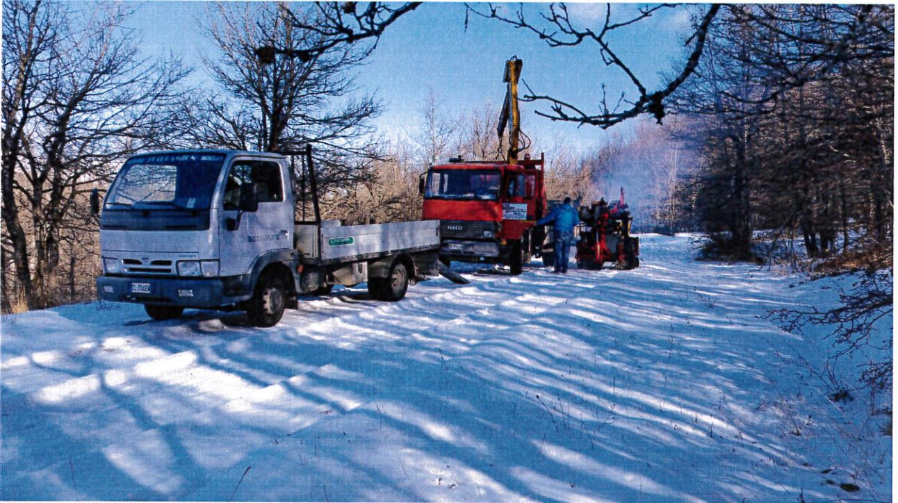
**Foto n°3** – Approntamento cantiere postazione N.2. Installazione trivella idraulica e penetrometro Pagani.
