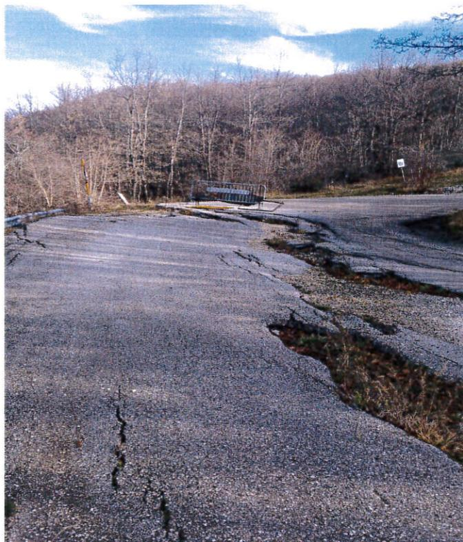
**Foto N.3:** Superfici di taglio multiple con gradini di altezza dell'ordine di 15-25 cm che hanno compromesso entrambe le carreggiate. Lo sviluppo della fessurazione favorisce le infiltrazioni idriche con accentuazione del fenomeno gravitativo attraverso il deterioramento delle proprietà geomccaniche ed incremento della spinta idraulica. Area di studio N.2
